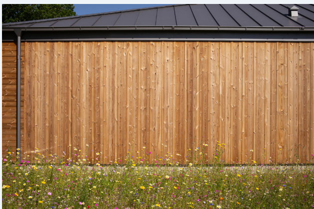
Frisch montierte Fassade
