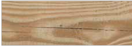
Trocknungsrisse (nach DIN zulässig)
