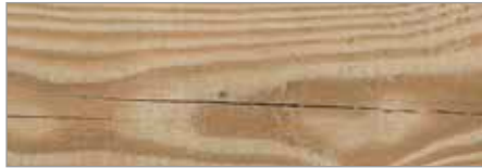
Trocknungsrisse (nach DIN zulässig)
