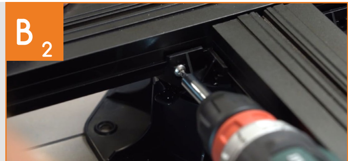
Unterkonstruktion ausrichten und mit Lagern verschrauben
