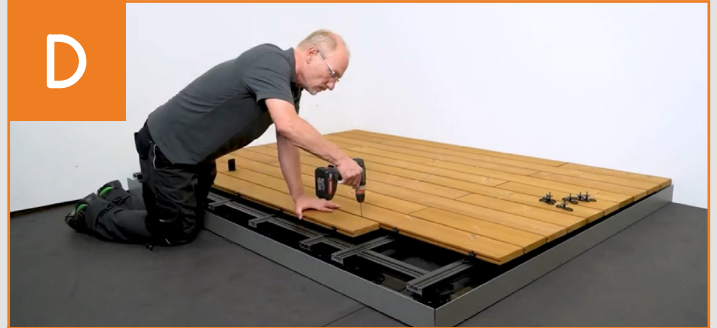
Verlegung der Dielen in der Fläche
