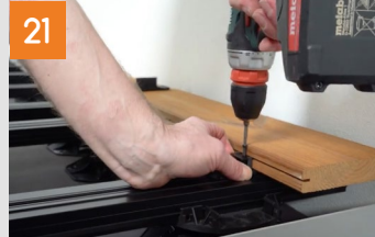
Verlegung der Dielen in der Fläche
