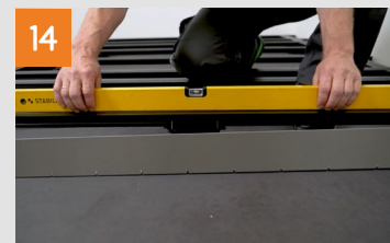
Unterkonstruktion ausrichten und mit Lagern verschrauben
