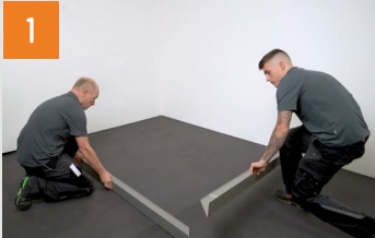
Seitenverblendung und Terrassenlager auslegen und Schienen einklicken
