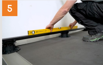
Schienen auf Terrassenlager klicken und ausrichten
