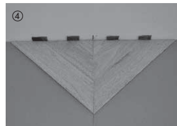
Zunächst jeweils drei linke und drei rechte Elemente ohne Klebstoff zu einem sogenannten „Kopf“ verbinden. Diesen entlang der Richtschnur ausrichten. Abstände zur Wand messen und die Elemente entsprechend zuschneiden. Die Abschnitte können am anderen Ende des Zopfes wieder genutzt werden. Die Richtschnur (Mitte des Bildes) verläuft genau durch die Raummitte. Die Anzahl der Reihen ergibt sich aus der Raumbreite dividiert durch die Deckbreite (523 mm) eines Elements (siehe Abb. 1).
