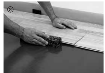
8 Bei Bedarf mit Schlagklotz leicht nachklopfen.
