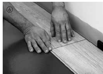
6 Die weiteren Elemente der ersten Reihe sind an den Kopfenden einzuklicken. Durch kurzen Druck auf den Querstoß rastet das Element im angrenzenden Element ein. Hierbei ist auf eine exakte Flucht der Elemente zu achten. Das letzte Element der ersten Reihe wird unter Berücksichtigung des Dehnungsabstandes von 10--15 mm zur Wand zugeschnitten und eingefügt.
