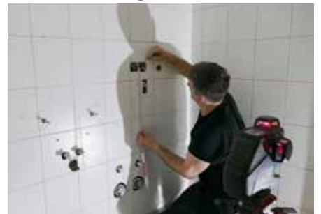
Fugenloser Plattenstoß
