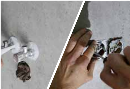
16. ÖFFNUNGEN MIT SILIKON AUS- SPRITZEN UND ARMATUREN MON- TIEREN
