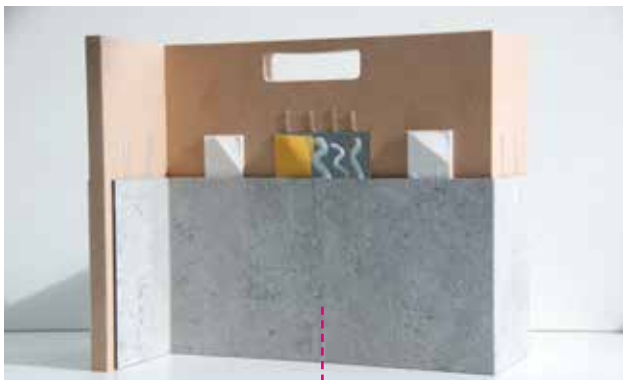
FUGENLOSER PLATTENSTOß
