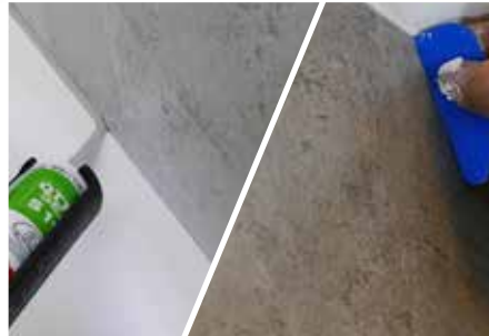
17. FUGEN MIT SILIKON ABDICHTEN UND SILIKON ABZIEHEN
