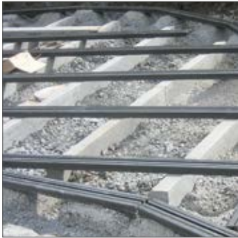
Montage auf Randsteinen
