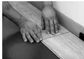
Die weiteren Elemente der ersten Reihe sind an den Kopfenden einzuklicken. Durch kurzen Druck auf den Querstoß rastet das Element im angrenzenden Element ein. Hierbei ist auf eine exakte Flucht der Elemente zu achten. Das letzte Element der ersten Reihe wird unter Berücksichtigung des Dehnungsabstandes von 10 -- 15 mm zur Wand zugeschnitten und eingefügt.
