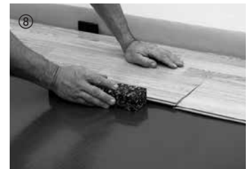
Bei Bedarf mit Schlagklotz leicht nachklopfen.
