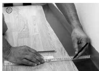
Die Elemente der letzten Reihe werden an der Längsseite unter Berücksichtigung eines Dehnungsabstandes von 10--15 mm zugeschnitten und eingepasst.
