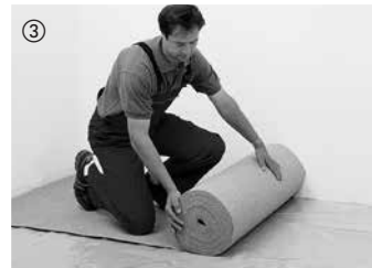
Zur Trittschalldämmung und zum Ausgleich kleiner Unebenheiten wird eine 2 mm dicke Korkdämmunterlage bündig ausgerollt. Alternative Dämmunterlagen finden Sie in unserem Zubehörangebot. Bitumenpappe eignet sich nicht zur Trittschalldämmung. Bei HARO Laminatboden mit Silent Pro® darf keine zusätzliche Dämmunterlage ausgelegt werden.
