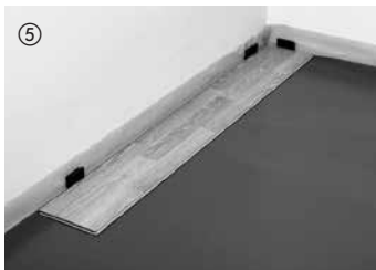
In der rechten Raumecke beginnend, werden die Elemente mit der Federseite zur Wand verlegt und mit Abstandskeilen fixiert (Dehnungsabstand zur Wand 10--15 mm).
