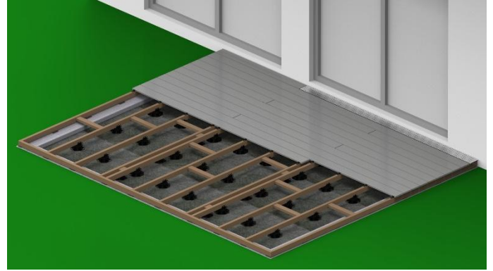
Bild 20. Verlegen Sie die weiteren WPC-Dielen auf der gesamten Fläche nach den vorherigen Schritten und prüfen Sie zwischendurch ob die Abstände zur Hauswand gleich sind. Ggf. muss nachkorrigiert werden, damit die vordere Diele gleichmäßig breit geschnitten werden kann.
