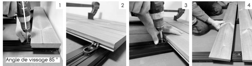
Avant la pose des lames de terrasse, il convient de prendre en compte la distance à respecter par rapport au mur. Elle dépend du type des lames de terrasse.
