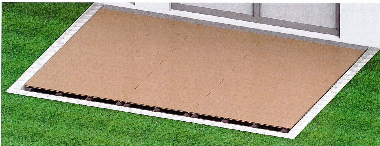
Bild 27. Achten Sie darauf das die letzte Diele möglichst gleich breit ist und nicht schmaler geschnitten werden muss.
