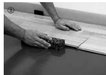
Bei Bedarf mit Schlagklotz leicht nachklopfen.
